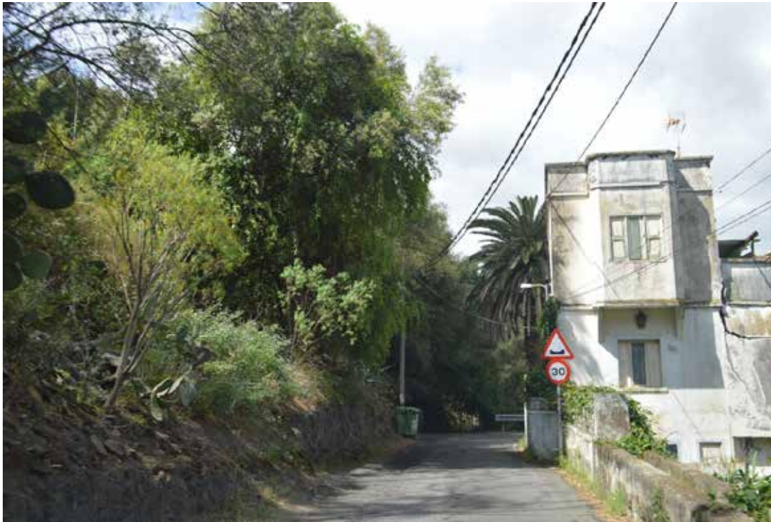
Ilustración 10: Carretera secundaria, sección estrecha. Los Olivos.
