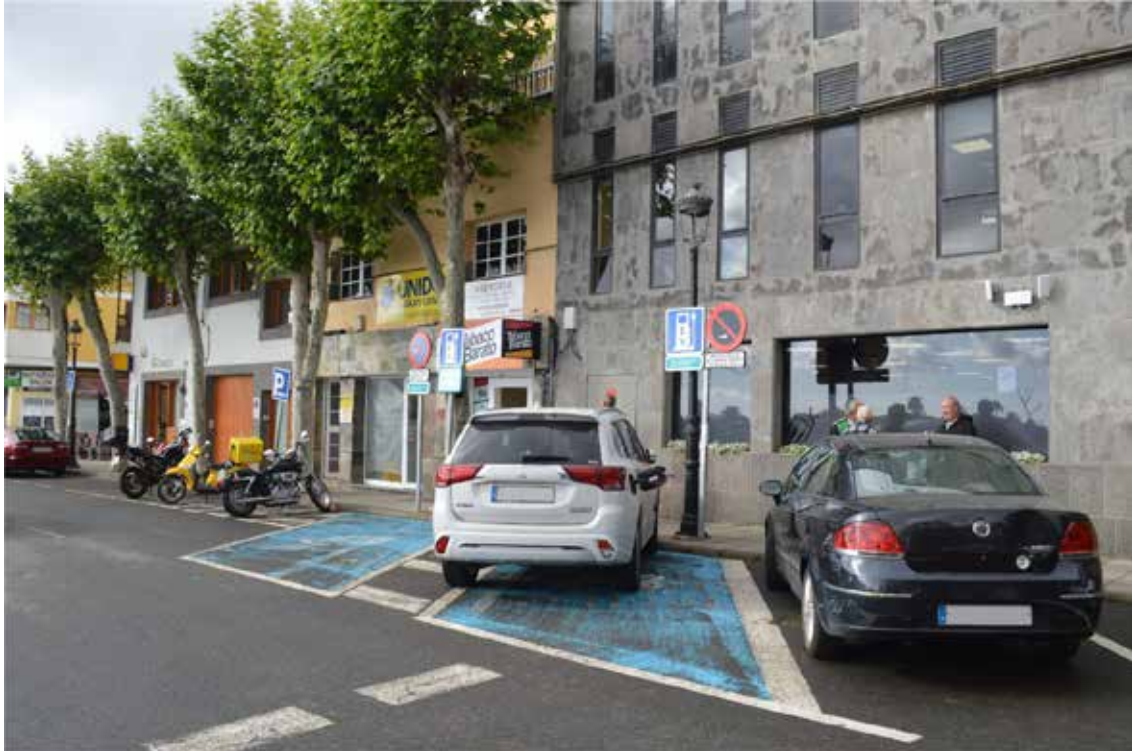
Ilustración 15: Punto de recarga de Vehículos Eléctricos. Ayuntamiento de Santa Brígida.
