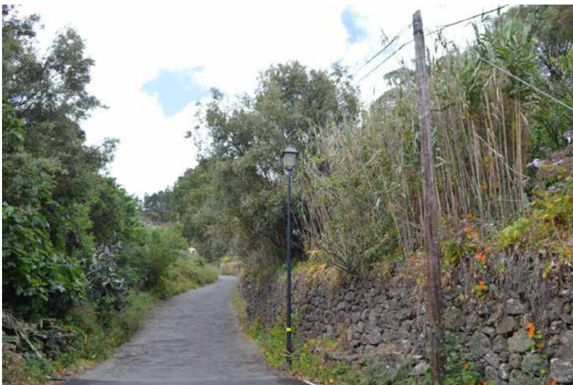
Ilustración 9: Carretera no acondicionada. El Gamonal.
