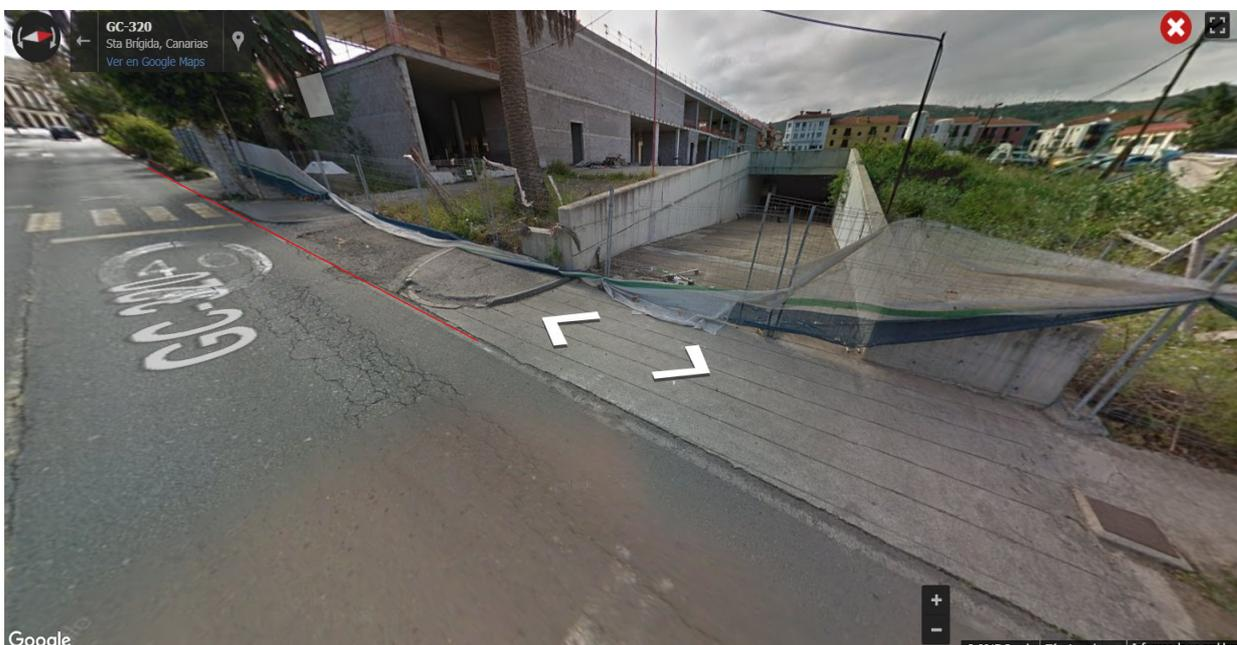
En la foto se puede apreciar el tramo con los problemas descritos, desniveles importantes, cambio de materiales de pavimento -rígido a térreos- problemas de encharcamientos, irregularidades, etc.
